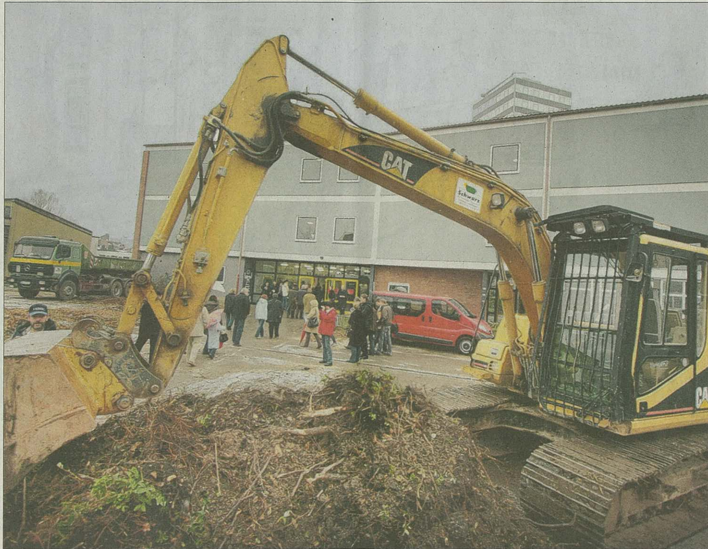
Die größte Baustelle des kommenden Jahres in der Stadt Leonberg: auf 810 Quadratmetern entsteht die neue Schulmensa
